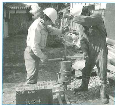
写真1 | 一般的に行われている人力のSWS試験
