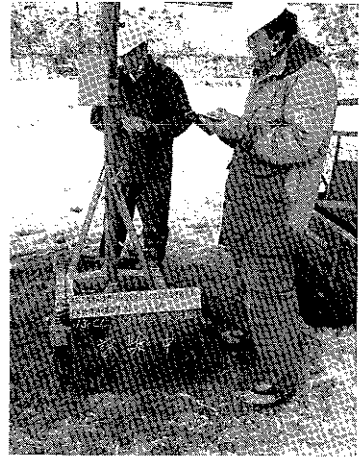
①オランダ式二重管コーン貫入試験状況
