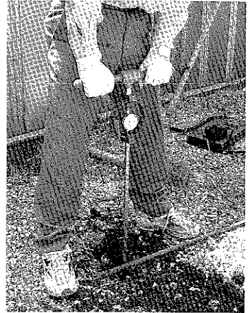
●ポータブルコーン貫入試験状況
