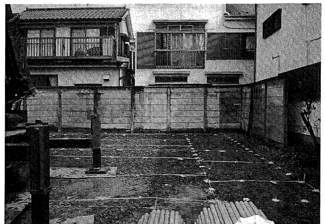
②施工完了状況
