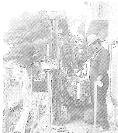
写真-2 施工状況
