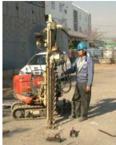
写真3 アンカー設置状況
