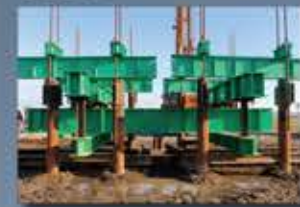
▲載荷試験状況 数多くの載荷試験により、どんな地盤にも確実な支持力を発揮することが確認されました。
