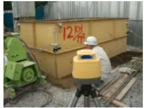
写真 1 10m 3 水槽を用いた沈下修正注入試験状況
