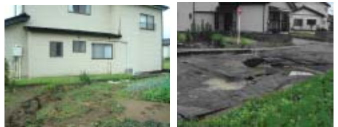
写真3 旧河道と土手に跨った住宅 写真4 旧河道上の噴砂跡
